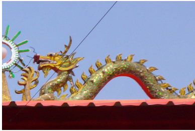
ภาพที่ 16 งานกระเบื้องตัดที่สันหลังคาอาคาร ทางเข้าศาลเจ้าแม่ทับทิม จ.เชียงใหม่
