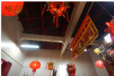
ภาพที่ 20 โครงสร้างอาคารแบบประยุกต์วัสดุคอนกรีตและเหล็ก ศาลเจ้าแม่ทับทิม จ.เชียงใหม่
