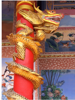
ภาพที่ 17 งานกระเบื้องตัดที่เสาอาคารทางเข้า ศาลเจ้าแม่ทับทิม จ.เชียงใหม่
