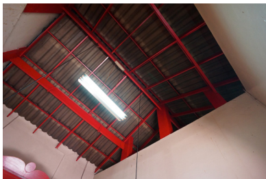
ภาพที่ 21 โครงสร้างอาคารแบบประยุกต์วัสดุคอนกรีตและเหล็ก ศาลเจ้าแม่ทับทิม จ.เชียงใหม่
