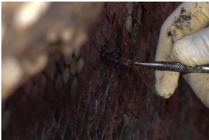
ภาพที่ 16 การใช้เทือกรัก (รักสมุก) เป็นวัสดุยึดติดกระจกเกรียบ
