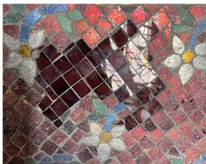
ภาพที่ 11 ความเสียหายที่เกิดจากการใช้อีพ็อกซีเป็นวัสดุยึดติดกระจกแก้วสมัยใหม่
