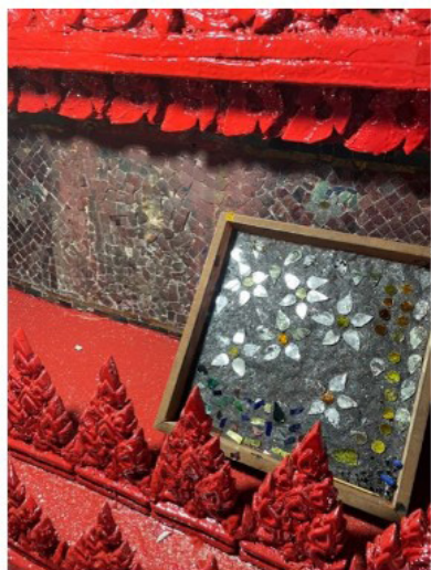
ภาพที่ 18 การเตรียมกระจกเกรียบที่ประดิษฐ์ขึ้นโดยตัดให้มีขนาดและรูปร่างตามลวดลายเดิมเตรียมไว้เพื่อการบูรณะ
