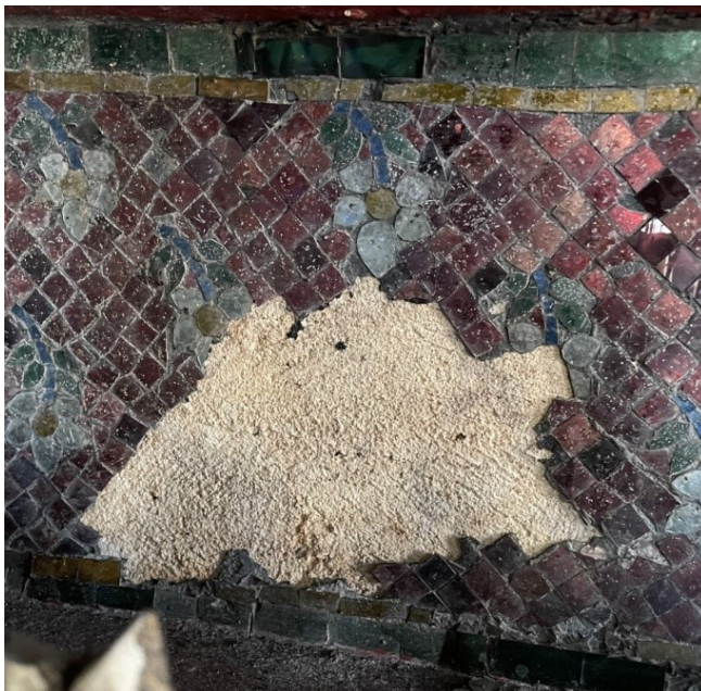
ภาพที่ 10 การผูกของผนังปูนและการล่อนออกของแผ่นกระຈกเกรียบที่ประดับถมพื้นห้องไม้
