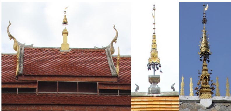
ภาพที่ 20 หลังคาซ้อนชั้นแบบไม่มีปีกนกของหอไตรวัดชัยมงคลซึ่งรับรูปแบบมาจากหอไตรกลุ่ม ช่างไทยอง (ซ้าย) การประดับสันหลังคาด้วยบราลีลายกระหนกและปราสาทเพื่องรูปแบบรองรับ ฉัตรตั้งที่หอไตรวัดมะเขือแจ้ (กลาง) และการประดับบราลีและปราสาทเพื่องแบบศิลปะไทย ประเพณีที่หอไตรวัดพระธาตุหริภุญชัย (ขวา)
