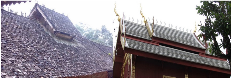
ภาพที่ 3 หลังคาซ้อนชั้นแบบไม่มีหลังคาปีกนกของศาลาบาตรวัดบ้านแจ็ก เมืองเชียงตุง (ซ้าย) และหลังคาซ้อนชั้นแบบไม่มีหลังคาปีกนกของหอไตรวัดหมูปึง (ขวา)
