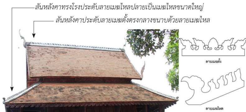
ภาพที่ 4 และ ภาพลายเส้นที่ 1 การประดับเครื่องหลังคาตามแบบอิทธิพลจากศิลปะไทลื้อที่หอไตรวัดประตูป่า
