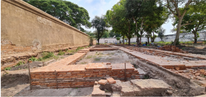
ภาพที่ 9 ส่วนหลัง กำแพงฉนวนกันพื้นที่ทางใต้ เป็นส่วนของข้าราชการฝ่ายใน ระหว่างบูรณะ ปรับสภาพหลังการขุดแต่ง
