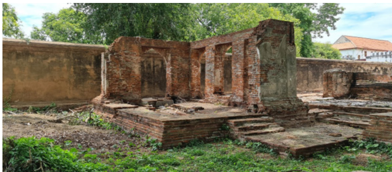
ภาพที่ 6 ส่วนหน้า พระปรางค์ซ้าย (ปีกซ้ายอยู่ทางใต้) ของพระที่นั่งสุทธาสรราช เหลือหลักฐานของช่องประตูหน้าต่าง ถัดไปทางเหนือคือซากฐานพระที่นั่งสุทธาสรราช
