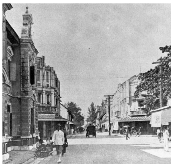
ภาพที่ 14 ภาพถ่ายเก่าตึกแถวบริเวณ แยกบ้านหม้อ ที่มา: สำนักหอจดหมายเหตุแห่งชาติ
