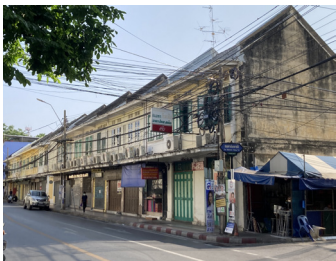
ภาพที่ 9 ตึกแถวริมถนนตะนาว (ปากทิศใต้) ใกล้แยกคอกวัว ที่มี ขนาดและรูปทรงสูงโปร่งขึ้น กันสาดด้านหน้าเป็นแผงคอนกรีต เสริมเหล็ก
