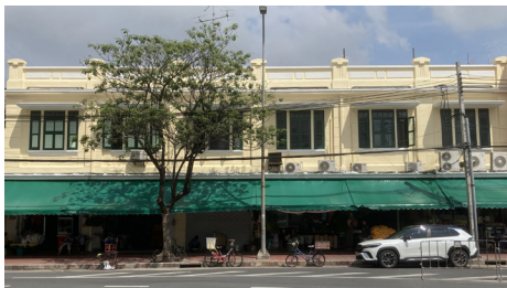
ภาพที่ 10 ตึกแถวบริเวณไปรษณีย์ วัดเลียบ ถนนจักรเพชร ที่มีลักษณะสูง โปร่ง ใช้ระบบเสาและคานรับน้ำหนัก
