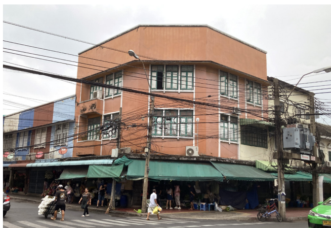
ภาพที่ 17 ตึกแถวห้วมุมแยกท่าโรงยาเก่า (ถนนบ้านหม้อ) เดิมน่าจะเคยเป็นพื้นที่ห้างขายยาและสถานพยาบาลมิตานี ที่ได้รับความเสียหายจากสงคราม
