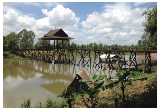
ภาพที่ 3 สะพานไม้อู่นุสรณ์สารคาม 150 ปี วัดป่าอาศิรวาสเกาะเก็ก (ที่มา : นักวิจัย : 2561)
