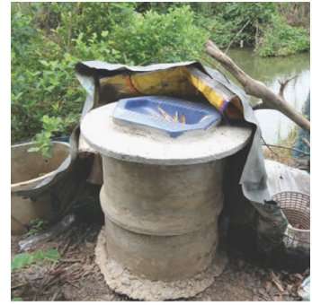
ภาพที่ 9 (ซ้าย) ยกเครื่องเรือนให้สูงกว่าระดับน้ำโดยใช้บล็อกคอนกรีตที่เตรียมไว้ในการทำกำแพงกันน้ำ (กลาง) ใช้ยางรถยนต์รองแผ่นไม้เป็นทางเดินติดต่อระหว่างบ้าน (ขวา) ยกสุขาชั่วคราวให้สูงระดับน้ำท่วมที่คลองบึงไผ่ ที่มา: วาดโดยคณะผู้วิจัย
