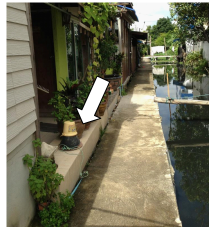
ภาพที่ 10 (ซ้าย) บ้านหลายหลังติดตั้งวัสดุทนน้ำ เช่น แผ่นเรียบ เพื่อป้องกันน้ำเข้าบ้าน (กลาง) เมื่อมีการต่อเติมปรับปรุงภายใน เจ้าของบ้านทำการยกพื้นในส่วนที่ทำใหม่ ส่วนพื้นเดิมต้องรอเก็บเงินให้พอต่อการก่อสร้าง (ขวา) บ้านบางแห่งทำการยกพื้นทั้งหลังสูงกว่าทางเดินชุมชน โดยอยู่ในระดับที่สูงกว่าระดับน้ำที่ท่วมเป็นประจำ ที่มา: ถ่ายภาพโดยคณะผู้วิจัย
