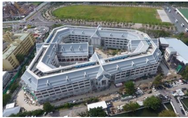
ภาพที่ 2 ภาพถ่ายมุมสูงอาคารศาลฎีกาขณะกำลังก่อสร้าง ปี พ.ศ.2562
