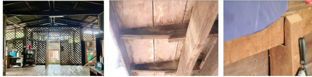
ภาพที่ 10 ตกแต่งผนังด้วยระแนงไม้ และการฝ้าไม้ของเรือนไทยพวน บ้านผือ หลังที่ 2
