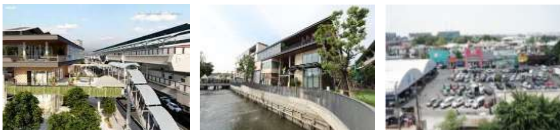
ภาพที่ 2 สภาพแวดล้อมของตลาดยิ่งเจริญภายหลังการปรับปรุงโครงการ “คิดจากคลอง” ที่มา : นักวิจัย
