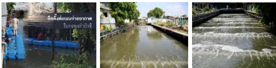
ภาพที่ 3 การติดตั้งระบบ ออกซิเดชันชีวภาพ (Biological contact oxidation) ของโครงการ “คิดจากคลอง” ที่มา : นักวิจัย
